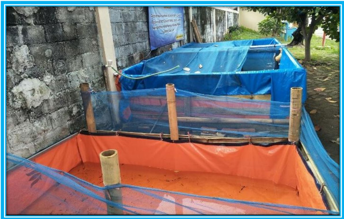
Pembuatan kolam ikan menggunakan terpal
